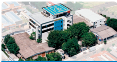
Vista aérea de unidade industrial
